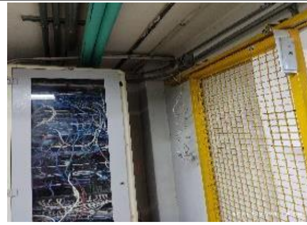
36.CABLEADO SIN ORGANIZAR, LAS PUERTAS NO SE PUEDEN CERRAR DEL TABLERO GENERAL SUBESTACIÓN DEL PISO 1 EDIFICIO CENTRO CONTROL
