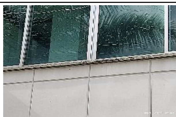
8.ALFAGIAS DETERIORADOS CON EL HIERRO EXPUESTO CENTRO DE MONITOREO
