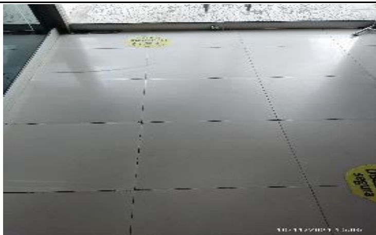
19. PISOS EN PORCELANATO RAYADOS Y MANCHADOS PORCELANATOS 1 PISO
