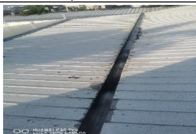
48. CUBIERTA DEL EDIFICIO DE FACTURACIÓN, CANAL QUE PRESENTA RESIDUOS EN TODA SU LONGITUD
