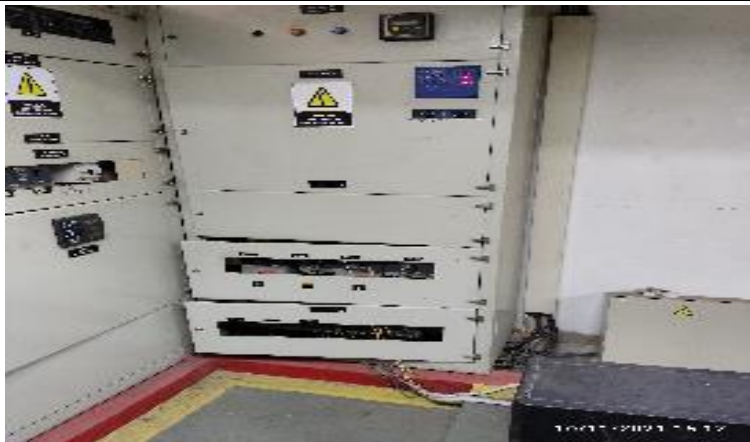
35.CABLEADO SIN ORGANIZAR, LAS PUERTAS NO SE PUEDEN CERRAR DEL TABLERO GENERAL SUBESTACIÓN PISO 1 EN EL EDIFICIO CENTRO CONTROL
