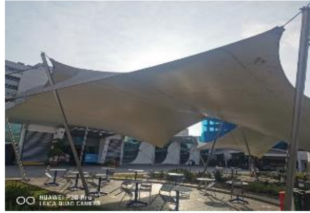
50. CARPA DE LA PLAZOLETA PRESENTA MANCHAS Y DESGASTE POR EL USO NO SE VE NINGUNA PERFORACIÓN
