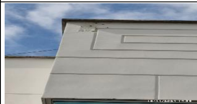
4.PERFORACIONES FACHADA EDIFICIO CENTRO DE MONITOREO
