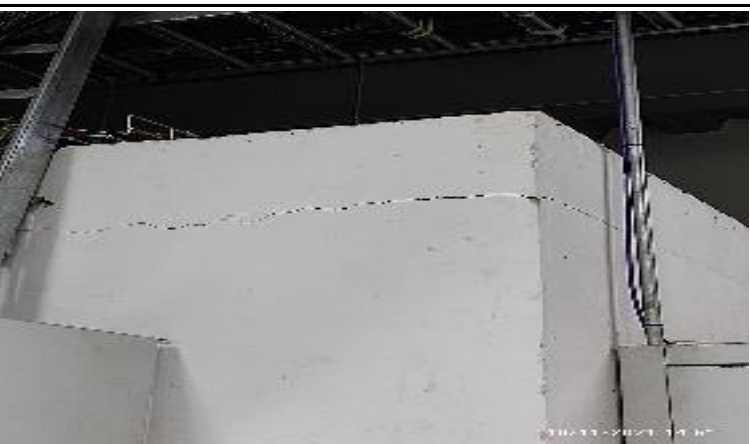
39.DILATACIONES EN MUROS SUBESTACIÓN ORIENTE SÓTANO
