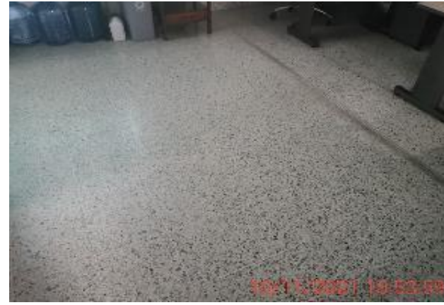
34.DILATACIONES EN PISO TABLETA TIPO GRANITO Y DESGASTE POR USO LABORATORIO 2 PISO
