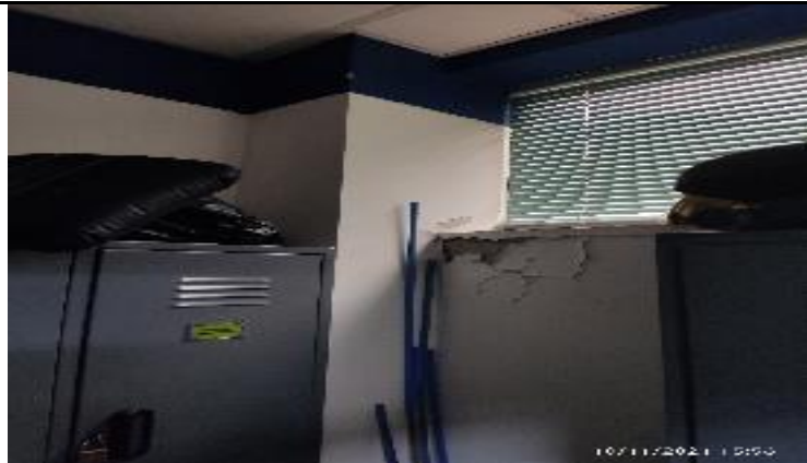
29. HUMEDAD EN VENTANA LOCKER LABORATORIO PISO 2 LOCALIZADA EN LA FACHADA EXTERIOR
