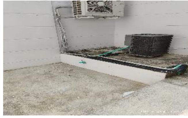
12. TUBERÍAS SIN SUJECCIÓN
