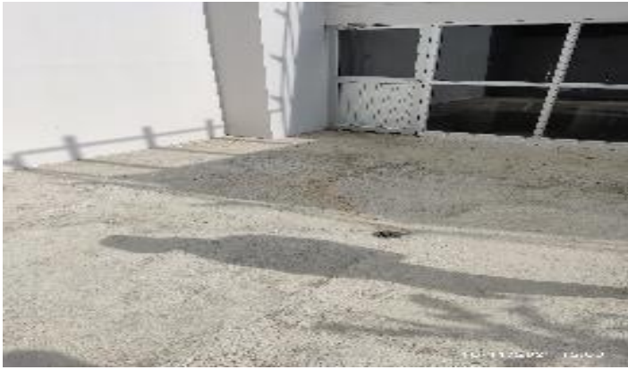
11. PISOS EN MORTERO MANCHADOS EN SALIDA DE EMERGENCIA
