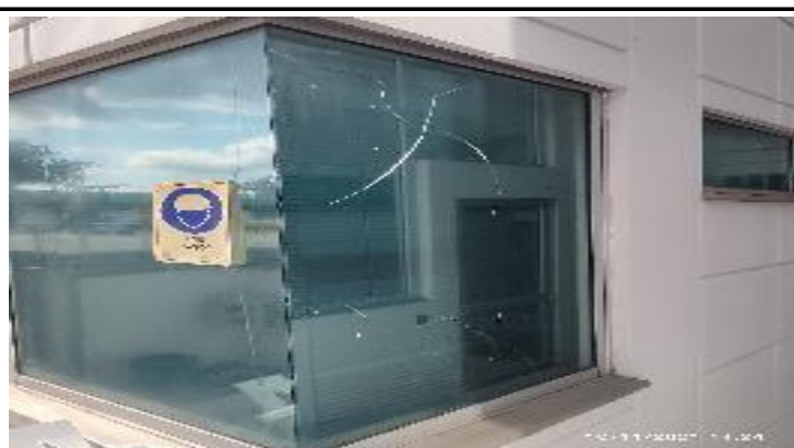
7.VENTANA DEL NIVEL 2 DEL LABORATORIO DE MEDIDORESCON EL VIDRIO PARTIDO
