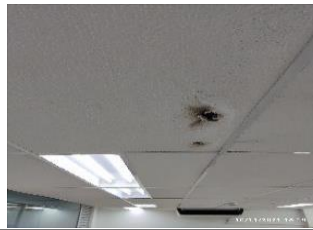
24. LÁMINAS DE CIELO RASO EN ICOPOR EN MAL ESTADO Y DESNIVELADAS EN LABORATORIO PISO 1
