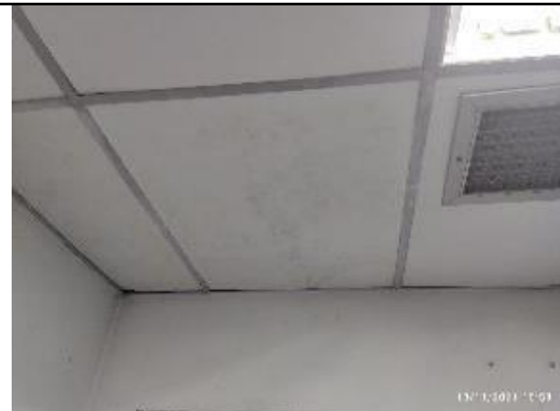
20. CIELORRASO EN ICOPOR MANCHADOS EN PRIMER PISO 1
