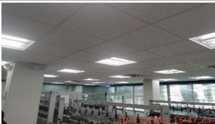
31. LÁMINAS DE CIELO RASO EN ICOPOR EN MAL ESTADO Y DESNIVELADAS EN LABORATORIO PISO 2
