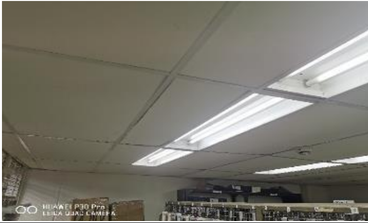
23. LÁMINAS DE CIELO RASO EN ICOPOR EN MAL ESTADO Y DESNIVELADAS EN LABORATORIO PISO 1
