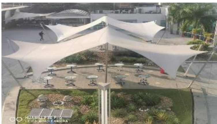
49. CARPA DE LA PLAZOLETA PRESENTA MANCHAS Y DESGASTE POR EL USO NO SE VE NINGUNA PERFORACIÓN
