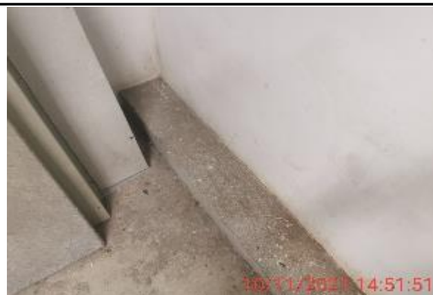
44. PLACA SIN ACABADOS SUBESTACIÓN PISO 1
