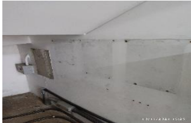
14. PAREDES DE CUARTO DE BOMBAS PERFORADAS Y SIN PINTURA
