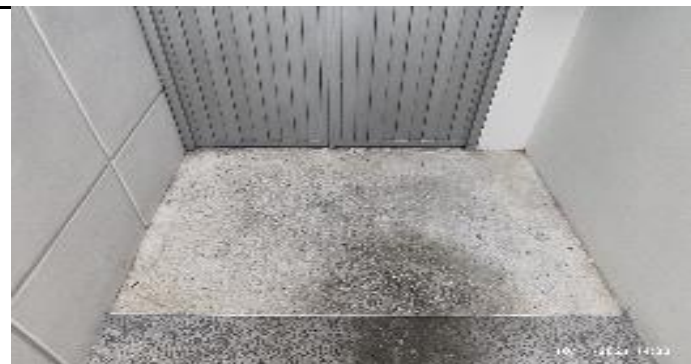
5.PISOS EN GRANITO MANCHADOS INGRESO BODEGA
