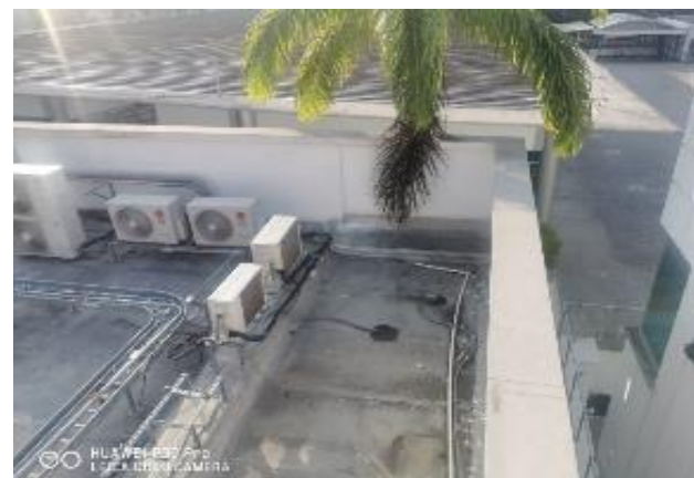
52. AZOTEA DEL EDIFICIO DE GERENCIA EL MANTO MUESTRA DESGASTE POR EL USO CONDICIONES DETERIORADA LA PINTURA POR EL USO
