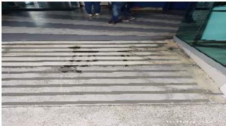
15. PISOS MANCHADOS Y DILATADOS POR EL INGRESO AL CENTRO DE CONTROL CALLE 24
