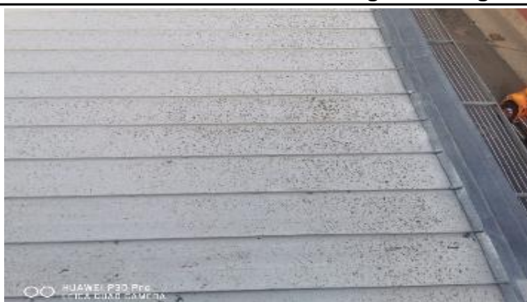
47. CUBIERTA DEL EDIFICIO DE FACTURACIÓN. PRESENTA UNAS MANCHAS EN TODA SU ÁREA
